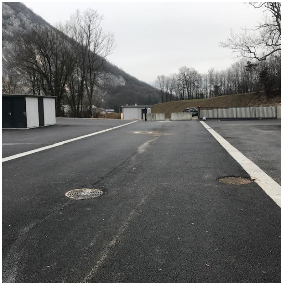
Aire d'accueil avant ouverture
