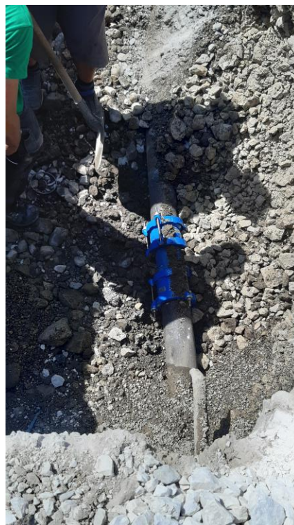
Fuite sous la RD1508 (Sillingy) et sa réparation
