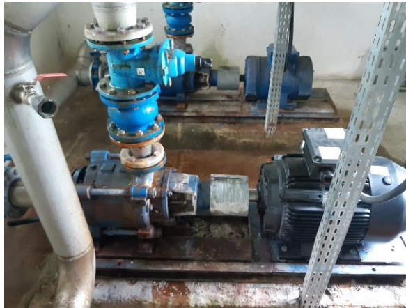
Pompage Echelles – Bornachon Avant rénovation
