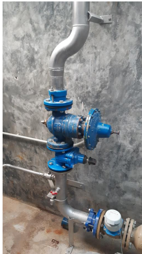
Réservoir d'Arzy Après rénovation
