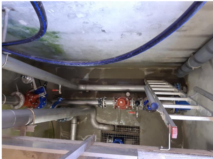
Réservoir de la Chaume Arrivée du secours de la Bonnasse
